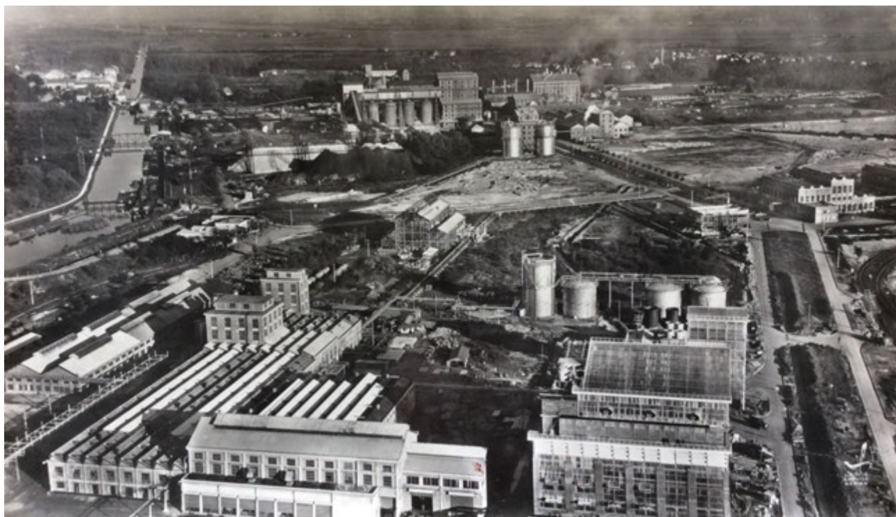
AD39, « La grande industrie chimique : Les usines Solvay, Damparis », Documentation aérienne pédagogique Lapie, Saint-Maur, 6Fi16(Tous droits réservés)
