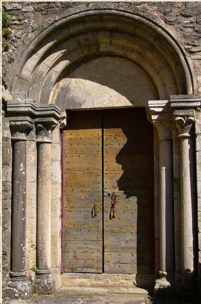
Porte latérale - église abbatiale de Gigny
